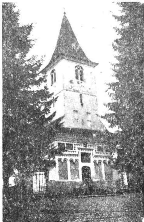
Fig. 13. — The church in Turnul Roșu—Porcești. Western façade.
